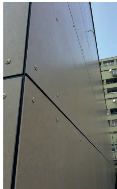
Fot. 3. System nitowania płyt Laminam
