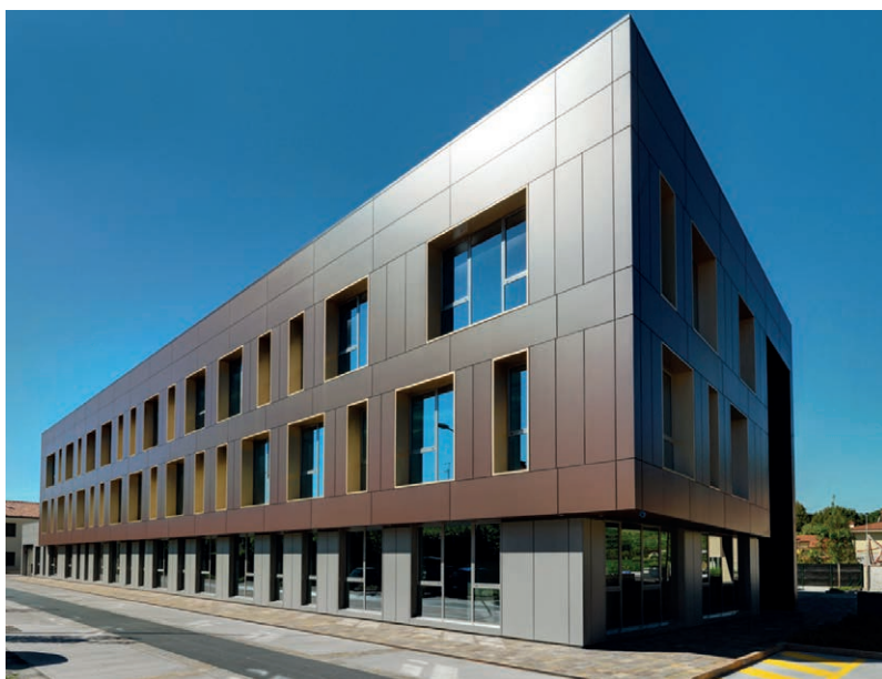
Fot. 1. Elewacja zewnętrzna budynku wykonana z wielkoformatowych spieków kwarcowych – seria Collection Moro firmy Laminam
